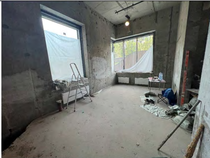
Фото №5. Общий вид помещения №4.
