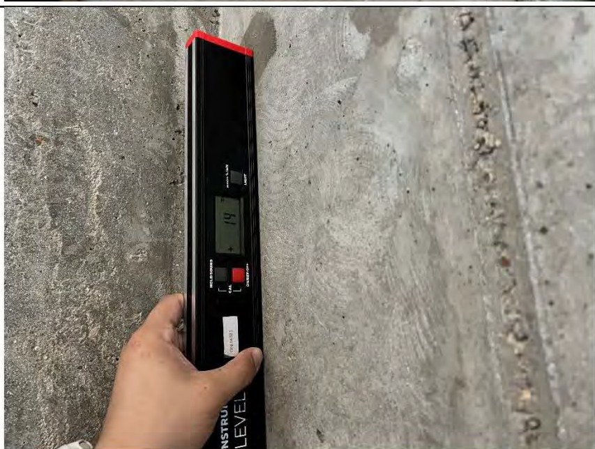
Фото №9. Измерение уровня стен в помещении № 1.
