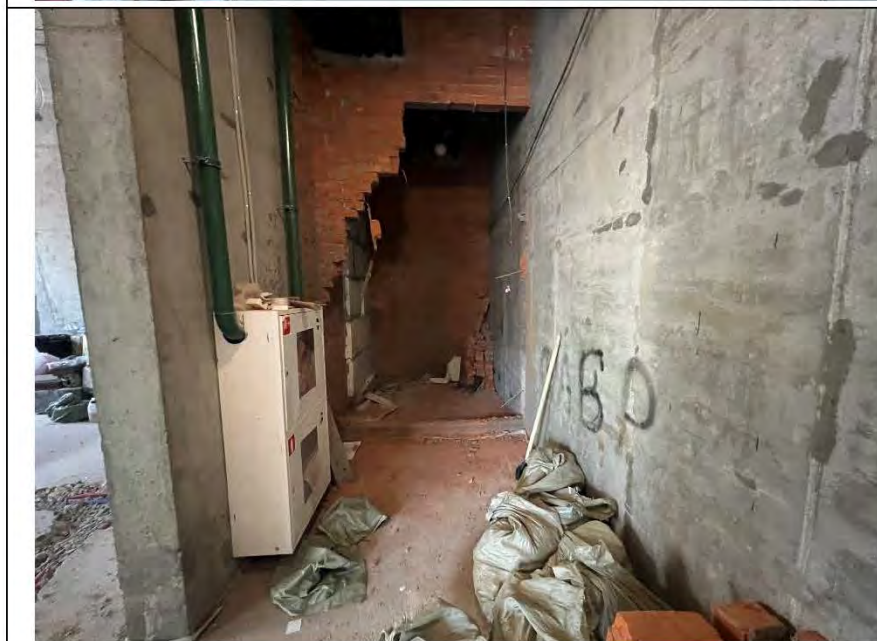
Фото №3. Общий вид помещения №2.
