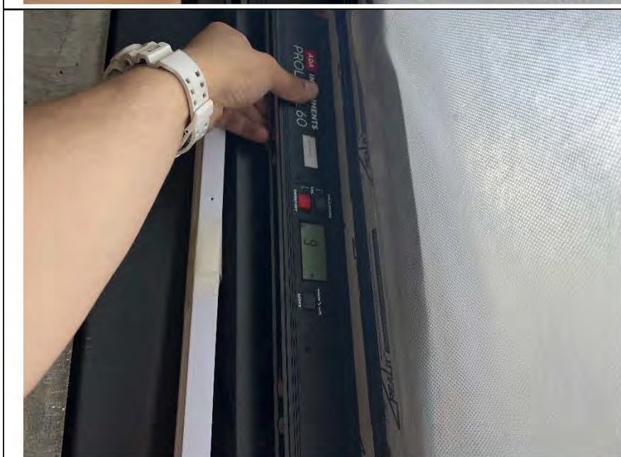
Фото №23. Отклонение коробки входного дверного блока составляет 6 мм..
