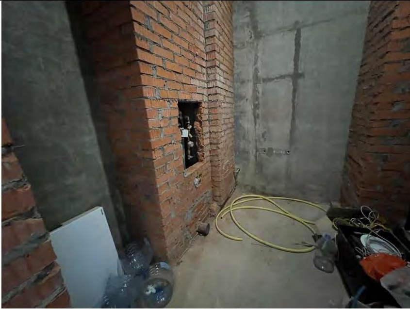
Фото №4. Общий вид помещения №3.
